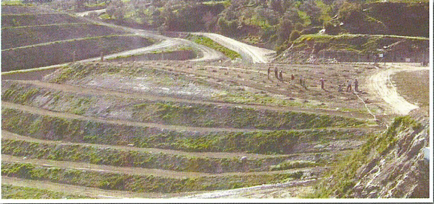
Şekil 1.11. Eski bir maden ocağının teraslama ile zeytin bahçesine dönüştürülerek rehabilitasyonu çalışması
